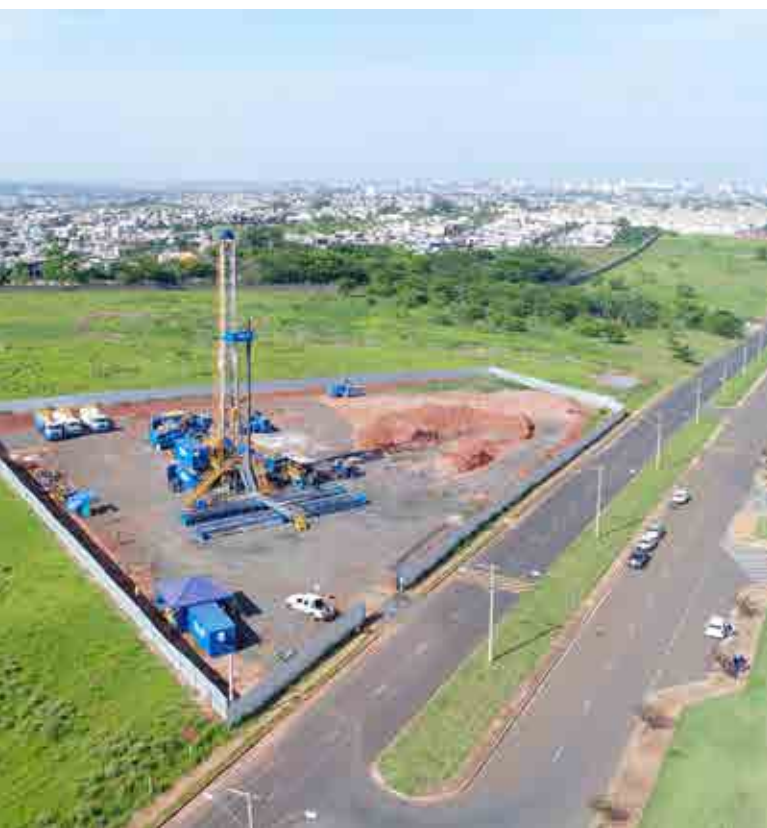
Mais água: Semae perfura novo Poço Guarani no bairro Maria Júlia, com profundidade de 1.200 metros e uma produção de 350 metros cúbicos (m3) de água por hora, para atender 31.500 pessoas, trabalhando num regime de 18 horas por dia. Investimento superior a R$ 12 milhões
