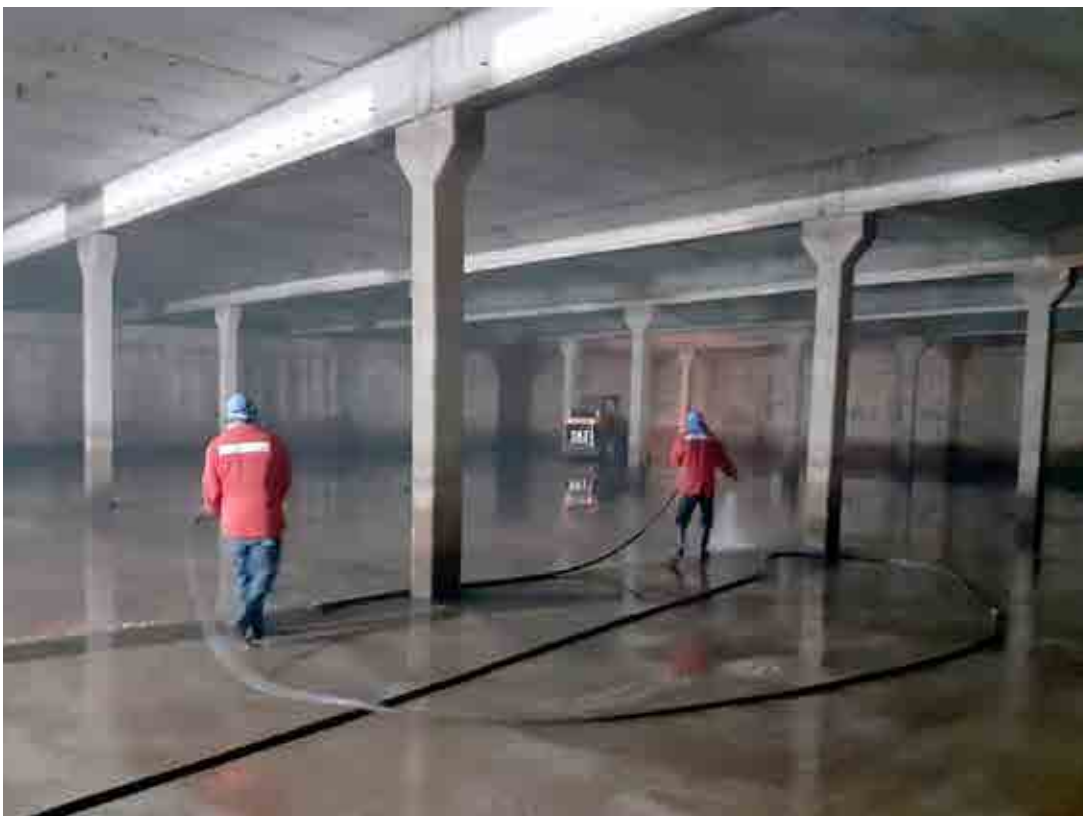
Maquinário faz serviço de manutenção de reservatório fechado em trecho do Centro Regional de Eventos, onde está o córrego Canela, que segue canalizado pelas avenidas José Munia e Andaló
