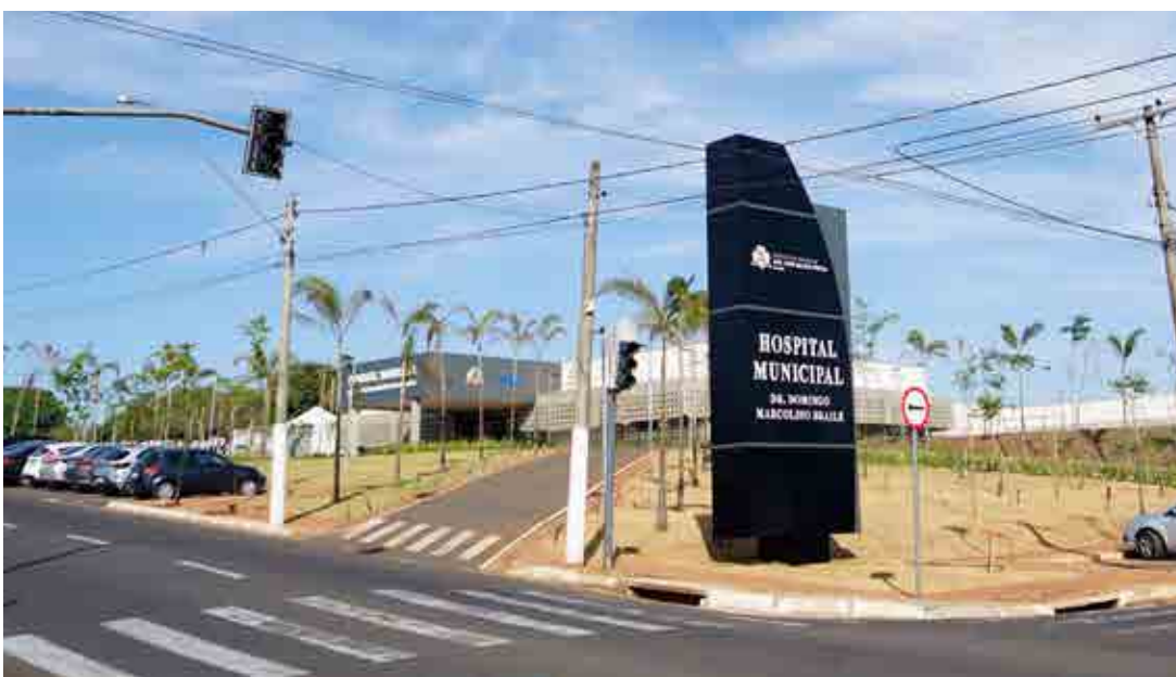
Prefeito inspeciona diferentes etapas da construção do Hospital Municipal, anunciado em 2019 e concluído em 2022
