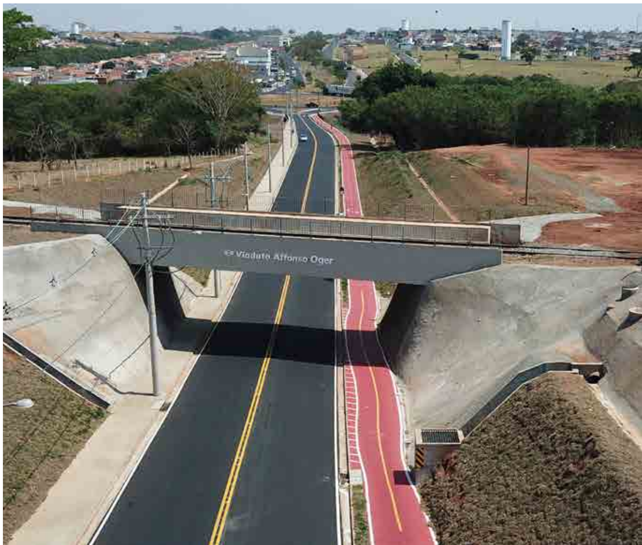
Conjunto de obras de mobilidade: Edinho, em vistoria a trechos do anel viário, pensou na mobilidade de forma ainda mais ampla; construiu outras importantes passagens, como o viaduto ferroviário Affonso Oger, na rua Izidoro Pupim, abaixo
