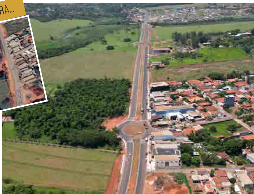
A vicinal da Vila Azul tem extensão de 1,4 km e investimento inicial de R$ 14,6 milhões. O acesso vai permitir a interligação com a vicinal que liga a Vila Azul a Potirendaba, com 6,8 km de extensão e investimento de R$ 17,7 milhões feito pelo governo estadual, mais R$ 55,5 mil em desapropriação por parte da Prefeitura
