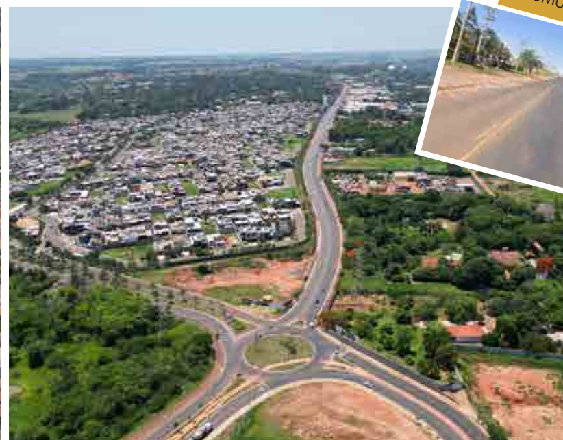
A duplicação da vicinal João Parise foi iniciada em 2022; são 3,7 quilômetros de extensão a um custo inicial de R$ 29,4 milhões, bancado pelo governo estadual, dinamizando o tráfego entre Rio Preto e o distrito de Engenheiro Schmitt, mais R$ 2,7 milhões em desapropriação por parte da Prefeitura
